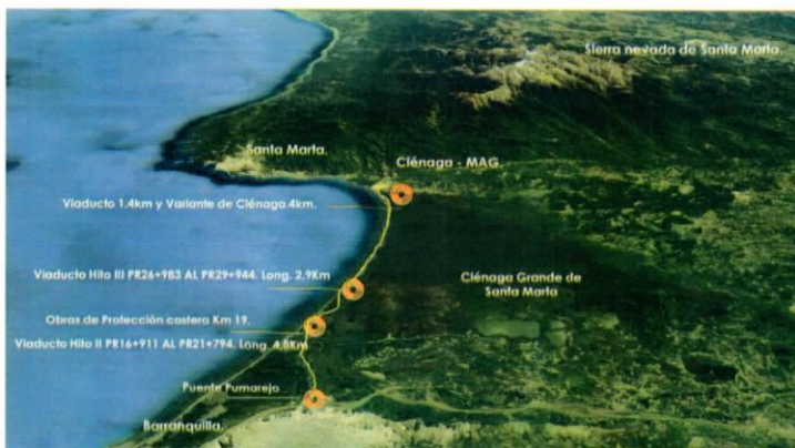
Grafica No. 2. Ubicación de sitios críticos que impactan el corredor vial, "TRONCAL DEL CARIBE" el departamento del magdalena por el fenómeno de erosión costera
