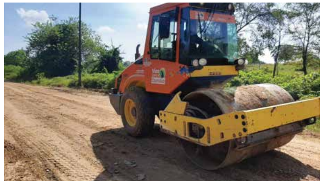
Lugar: Pivijay Observaciones: Maquinaria operando
