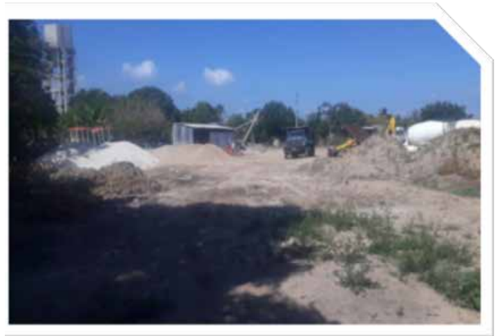
Ilustración. Inicio de obras, Parque de Guáimaro – Salamina
