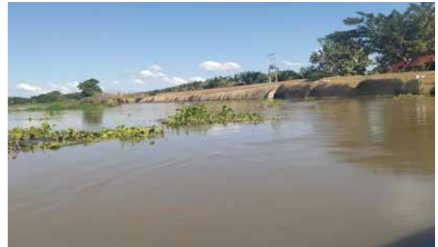
Lugar: Municipio de Salamina, vía que conduce de Salamina al Piñón obras para la protección de la orilla de la margen derecha del río Magdalena K2+100 km 2.1 Observaciones:
