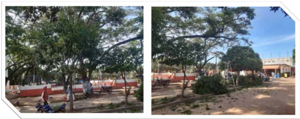
Ilustración 31. Inicio de obras - Parque Guamal
