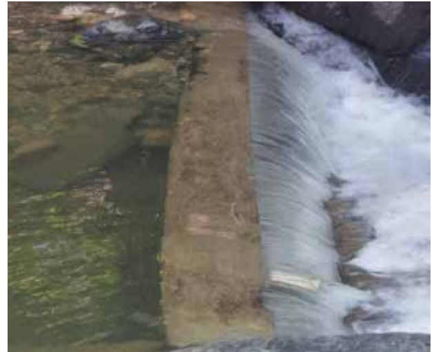
Lugar: Zona Bananera - Guáimaro Observaciones: Mangueras para captación ilegal en la quebrada el Guáimaro.
